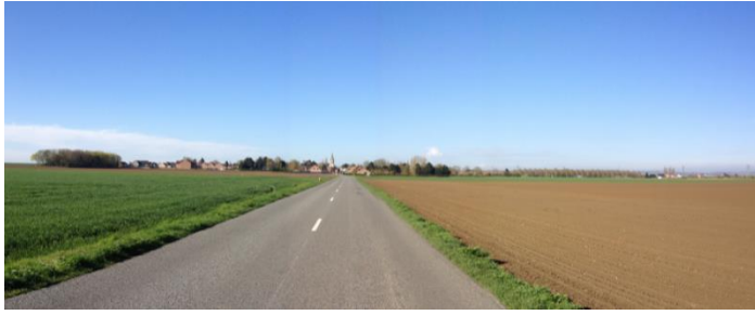
Vue globale sur l'entrée Est voie Maréchal Leclerc
