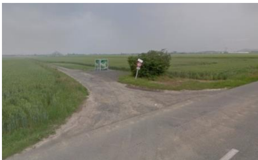
Vue sur la liaison existante fermant le compartiment urbanisé côté droit de la voie
